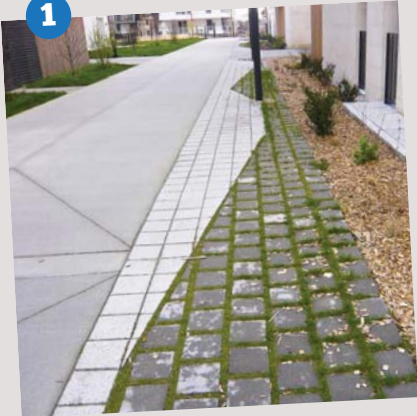
1 Pavés non jointés et tranchée d'infiltration Projet Ginko à Bordeaux (33)
