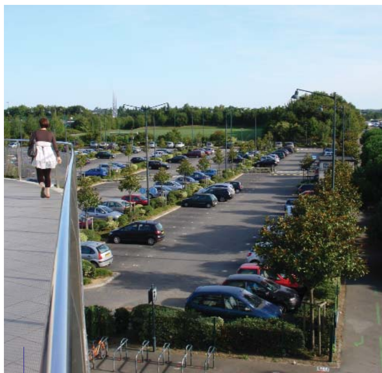
Le parc-relais de la Poterie à Rennes récupère les eaux pluviales en structure réservoir Source : AUDIAR (Agence d'Urbanisme et de Développement Intercommunal de l'Agglomération rennaise)
