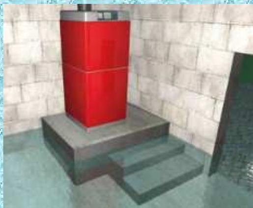
*Protection d'un équipement de chauffage par surélévation*
