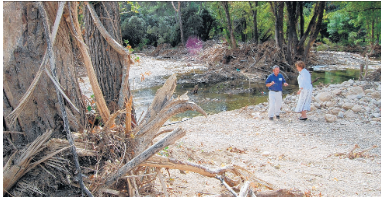
Le 16 septembre, trois mois après la catastrophe : débris et amas de végétaux encombrant encore la Nartuby en amont de Draguignan. Le DL
