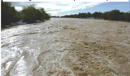
L'Argens en crue sur le pont de la RN98
